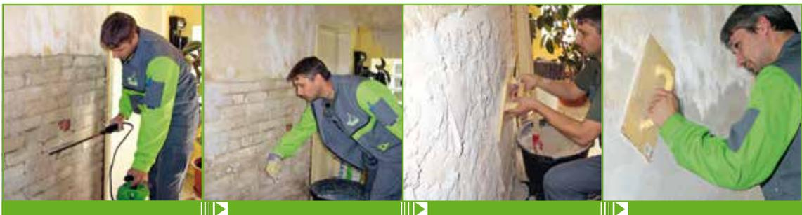
오래된 미장을 제거한다. 탈락부위나 구멍 등 손상 부위를 KÖSTER Repair Mortar Polysil® TG 500 을 스프레이 하여 소금기를 안정화 시키고 바탕면을 단단하게 한다.
